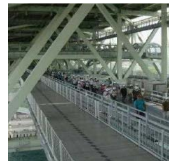
【明石海峡大橋管理路】
