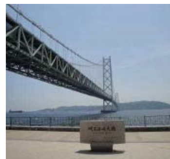
【明石海峡大橋全景】
